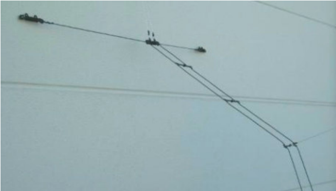
Abbildung 4: Dipol mit Hühnerleiter (abgewinkelt mit Seil)
